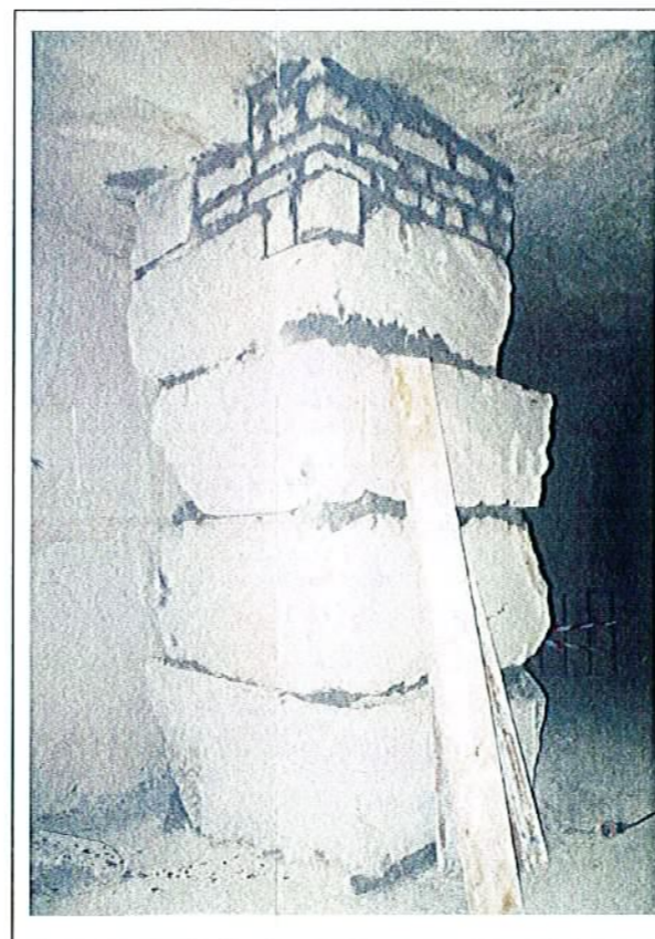
Vue sur un pilier maçonné pour renforcer la stabilité du toit des galeries
